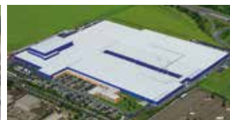
Hörmann KG Ichttershausen, Allemagne
