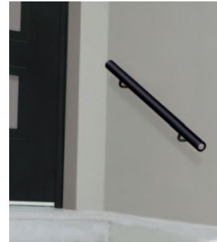
MC tube rond Ø 40x2 sur cavalier
