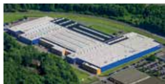
Hörmann KG Eckelhausen, Allemagne
