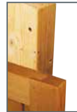
Volet à cadre rapporté avec une traverse intermédiaire
