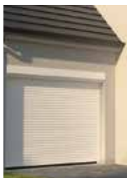
Pose en tunnel extérieure
